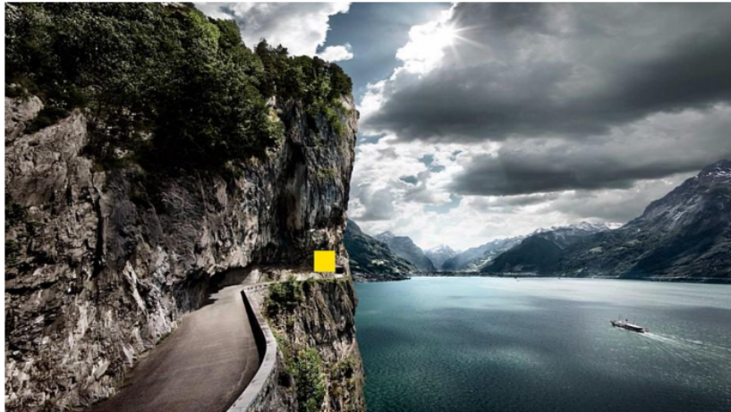
Die neue, monumentale Bildwelt heroisiert die Bauwerke und Arbeit von Walo und zeige ihre Weitsicht und Haltung, über die Dinge hinaus zu denken. (Bild: zVg.)
